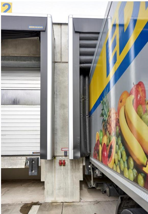
**Bild 3:** Die dreiseitig aufblasbaren Torabdichtungen passen sich den unterschiedlichen Lkw-Größen an und verhindern so weitestgehend das Eindringen von Wärme.
