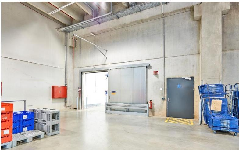
**Bild 5:** Feuerschutz-Schiebetore von Hörmann trennen im Brandfall die einzelnen Lagerbereiche voneinander ab. Die angrenzende Feuerschutztür aus Stahl ermöglicht den Personendurchgang.
